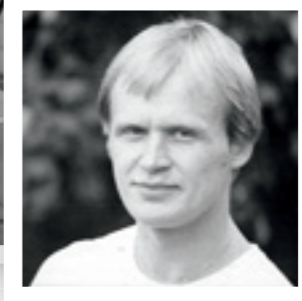
Alla. Rauno Joki Mekaanikonkadun toimitalon perustusten muurauksen aikoihin 1982.
